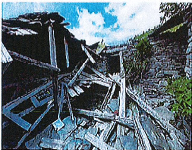
Photos de la bâtisse existante - Vu Intérieur – Façade Ouest,
