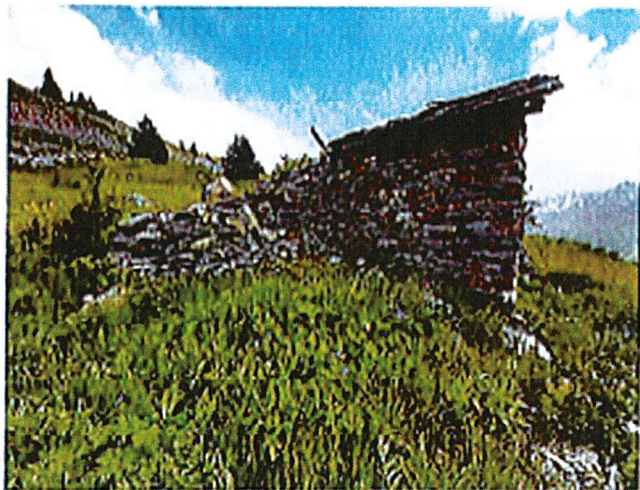
Photos de la bâtisse existante – Façade Nord,
