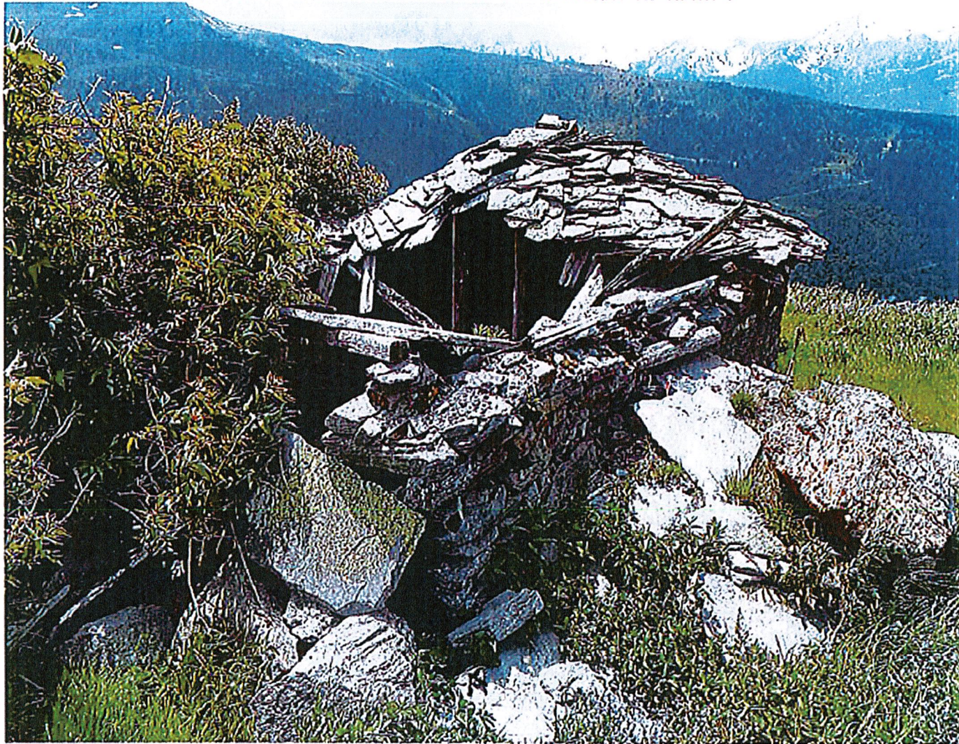
Photo de la bâtisse existante – Façade Est et Nord & Tolture.
