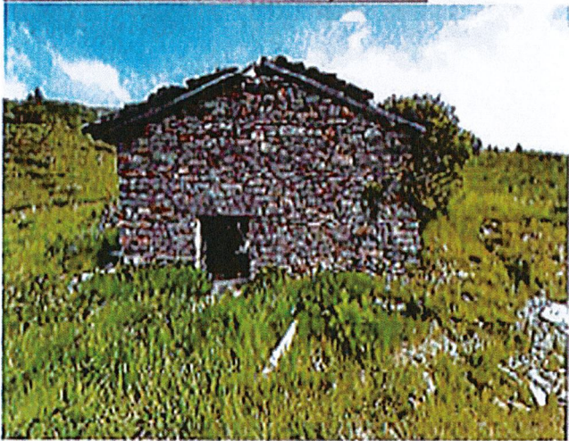
Photos de la bâtisse existante – Façade Ouest,
