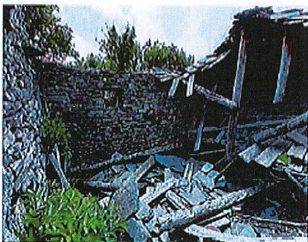
Photos de la bâtisse existante - Vu Intérieur – Façade Sud,
