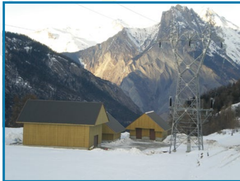
Poste source du hameau du Col (Valloire).
